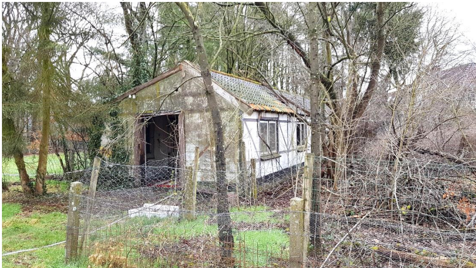
Foto 1. Het te slopen gebouw
