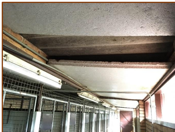
Figuur 2.3: afgesloten ruimte onder het dak
