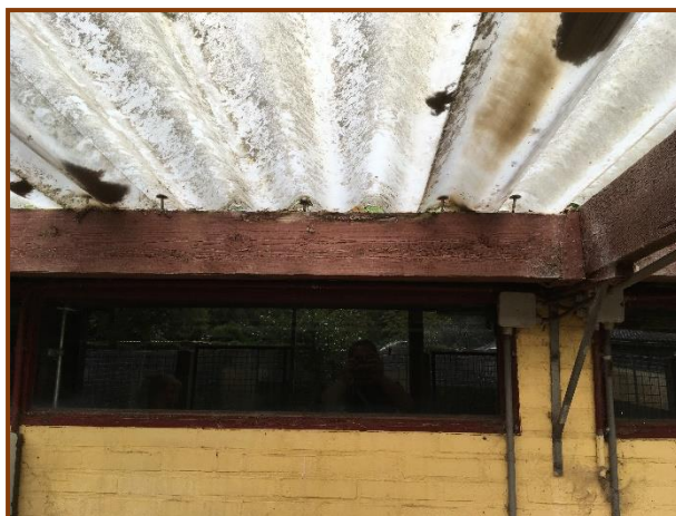
Figuur 2.4: golfplaten dak
