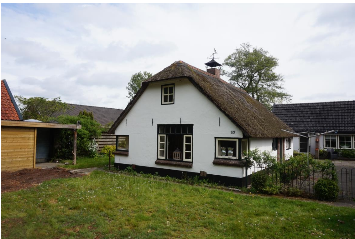
Figuur 2.3. Te slopen woning met riet gedekte kap.
