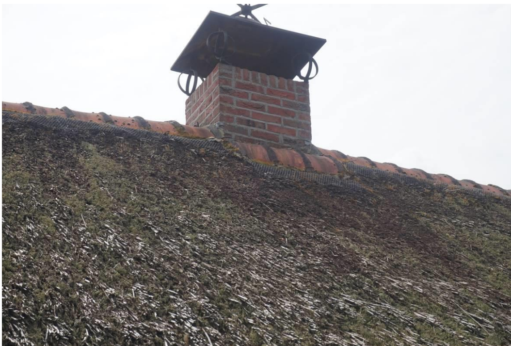
Figuur 5.3. Rieten kap, te verbouwen woning, afgewerkt met gaas en nokvorsten.
