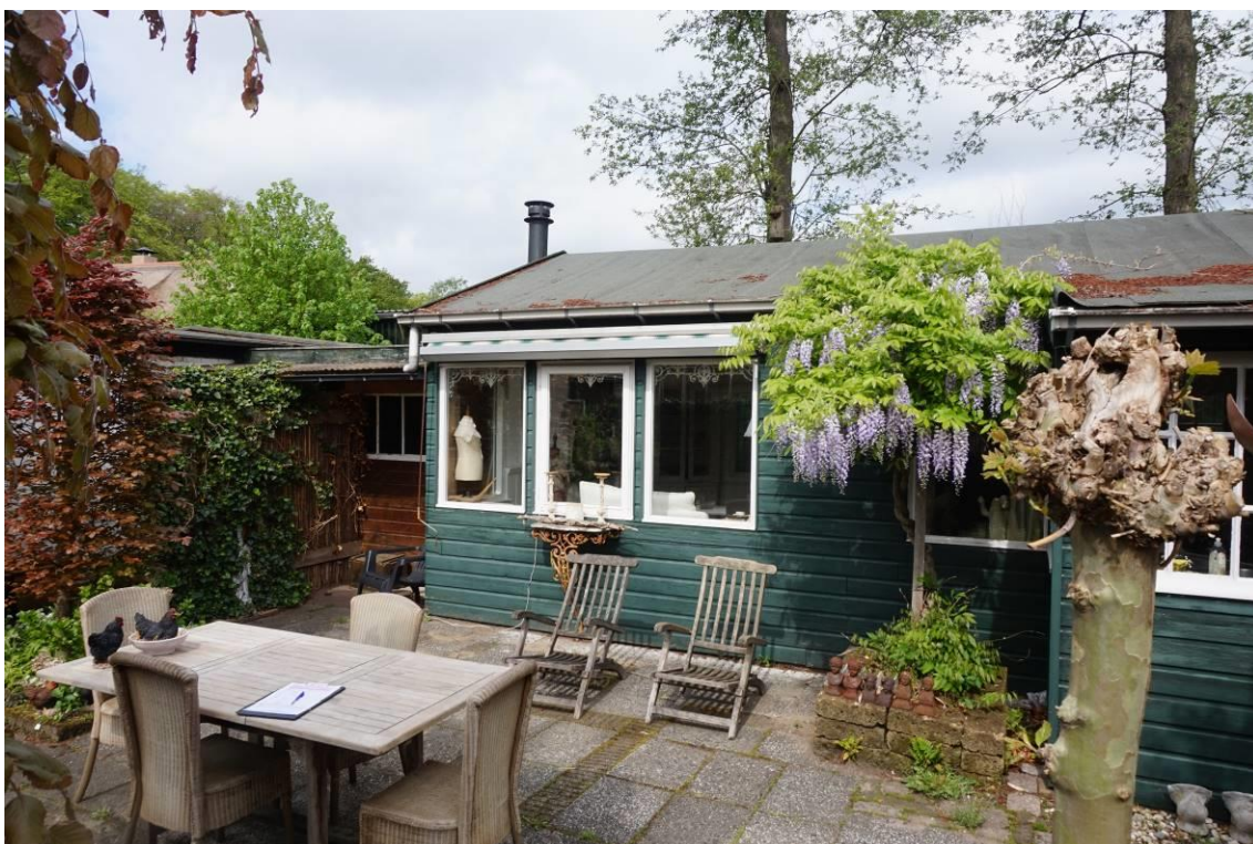
Figuur 5.4. Naadloos met dakleer afgewerkte kap van de achterste, te slopen woning.
