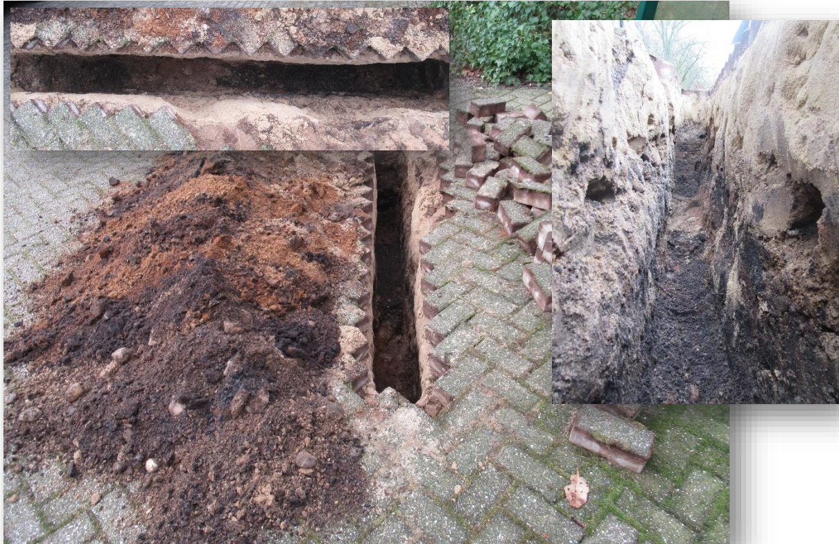
Foto 5: proefsleuf 4 meter ten westen van de boom Inzet: boven- en zijaanzicht proefsleuf
