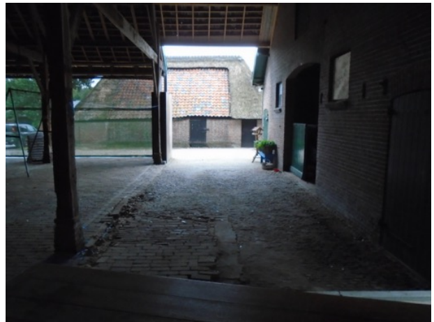
kapschuur en schaapskooi
