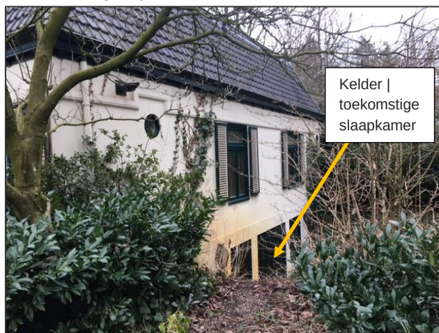
Figuur 6 Foto zuid(oost)gevel koetshuis
