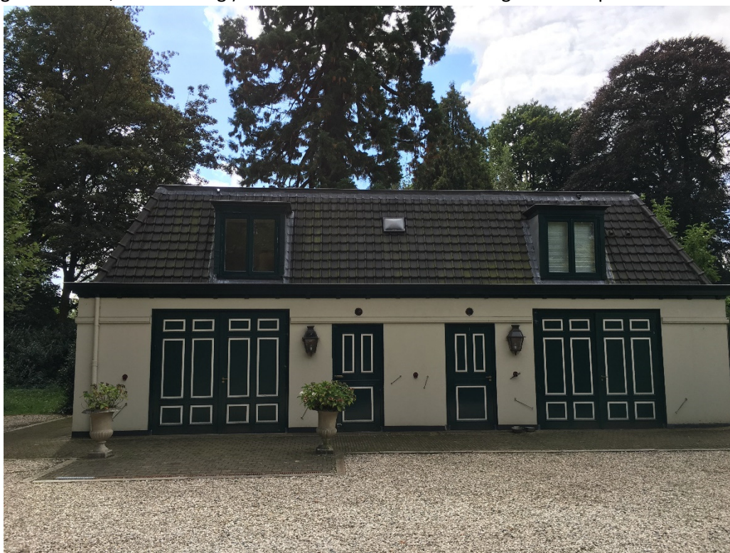
Koetshuis omvormen naar 2 appartementen, grind als infiltrerende verharding tot nieuwbouw doorzetten.
