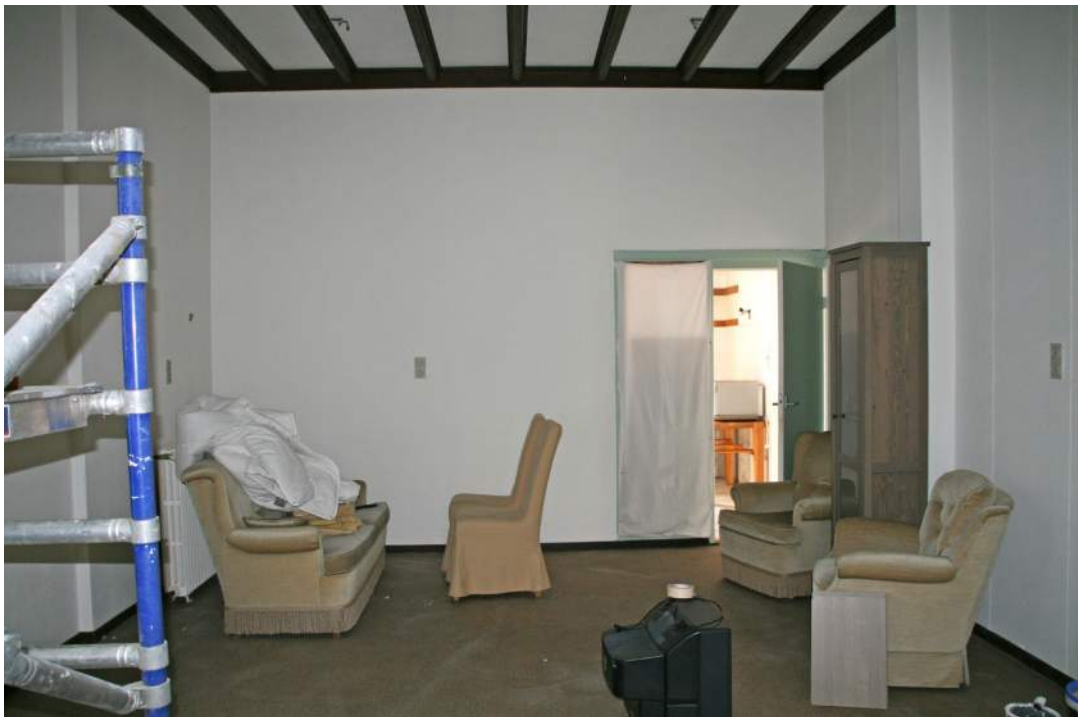
Afb. 38 Ruimte 0.04, gezien naar het zuiden. Rechthoekige ruimte die aanvankelijk kleiner was en naar het zuiden toe is verlengd. Een muurdam in de westwand is het restant van de originele muur. Het toegevoegde deel deed aanvankelijk dienst als pantry.
