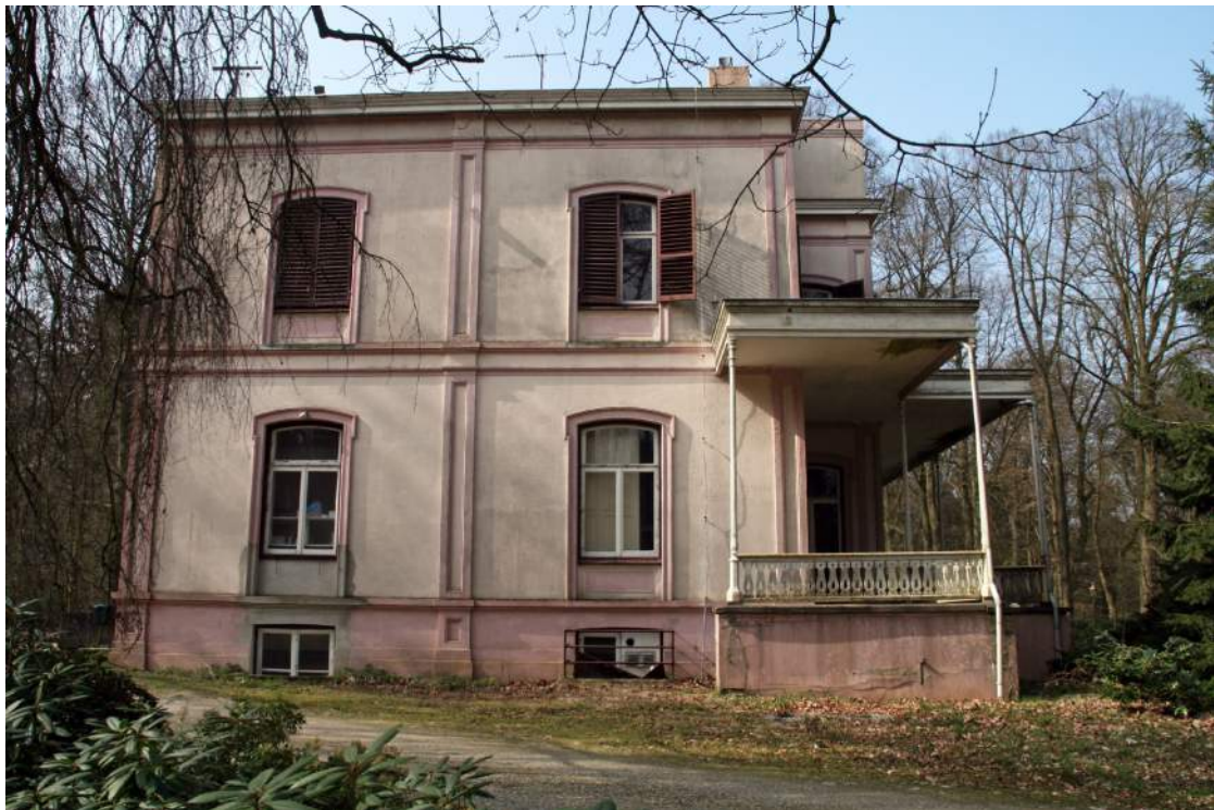
Afb. 27 De oostgevel met rechts de opgang naar de veranda. Het grijs gepleisterde gedeelte in onder het linker bel-etagevenster toont de plaats waar in een tussenperiode een trap heeft gestaan.
