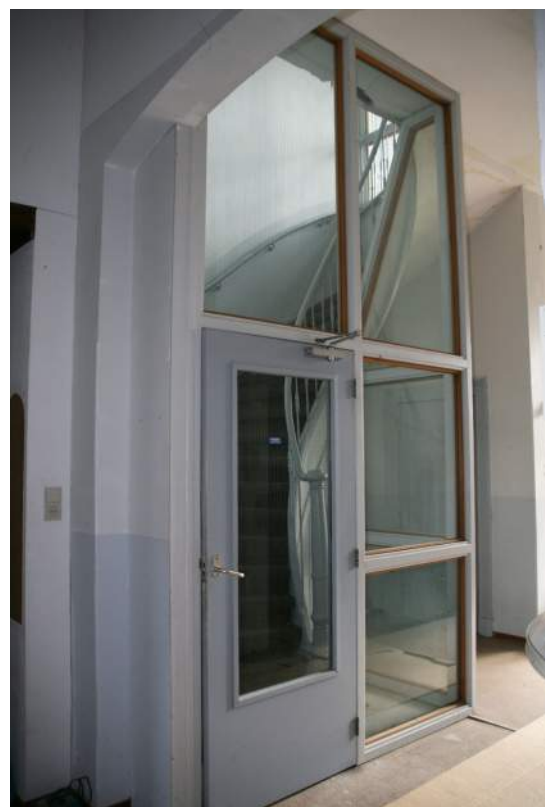
Afb. 44 Trappenhuis (0.11), gezien naar het zuidoosten. De trap is zichtbaar door de vermoedelijk rond 1990 geplaatste glazen afscheiding.
