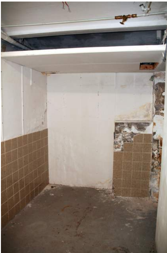
Afb. 34b Ruimte -1.06, gezien naar het zuiden.
