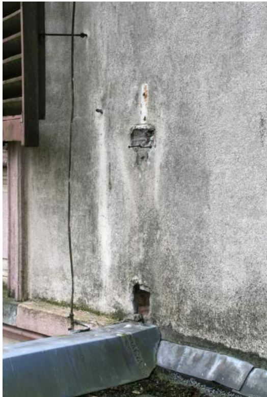
Afb. 26 Sporen van de aansluiting op de oostelijke gevel (afb. 27) van de verwijderde balkonbalustrade op de veranda.
