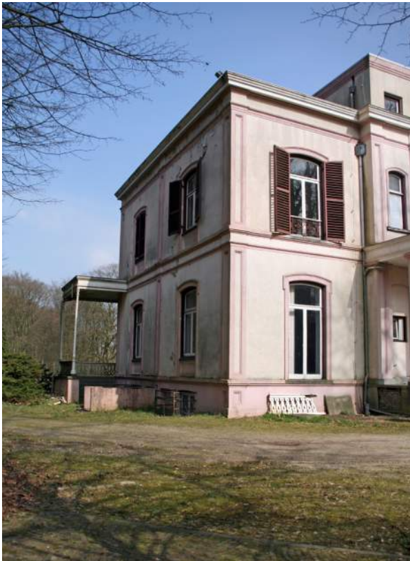
Afb. 22 De westgevel (links) gezien vanuit het zuidwesten.
