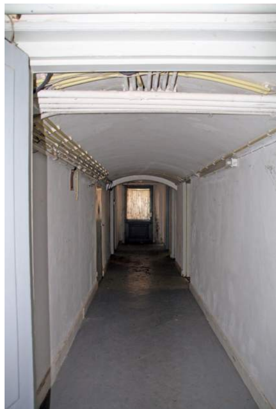
Afb. 33 Centrale gang (-1.03) in het souterrain, gezien naar het westen, naar de buitendeur.
