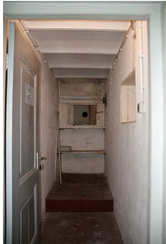
Afb. 32 Ruimte -1.02a, met links de oorspronkelijke deur.
