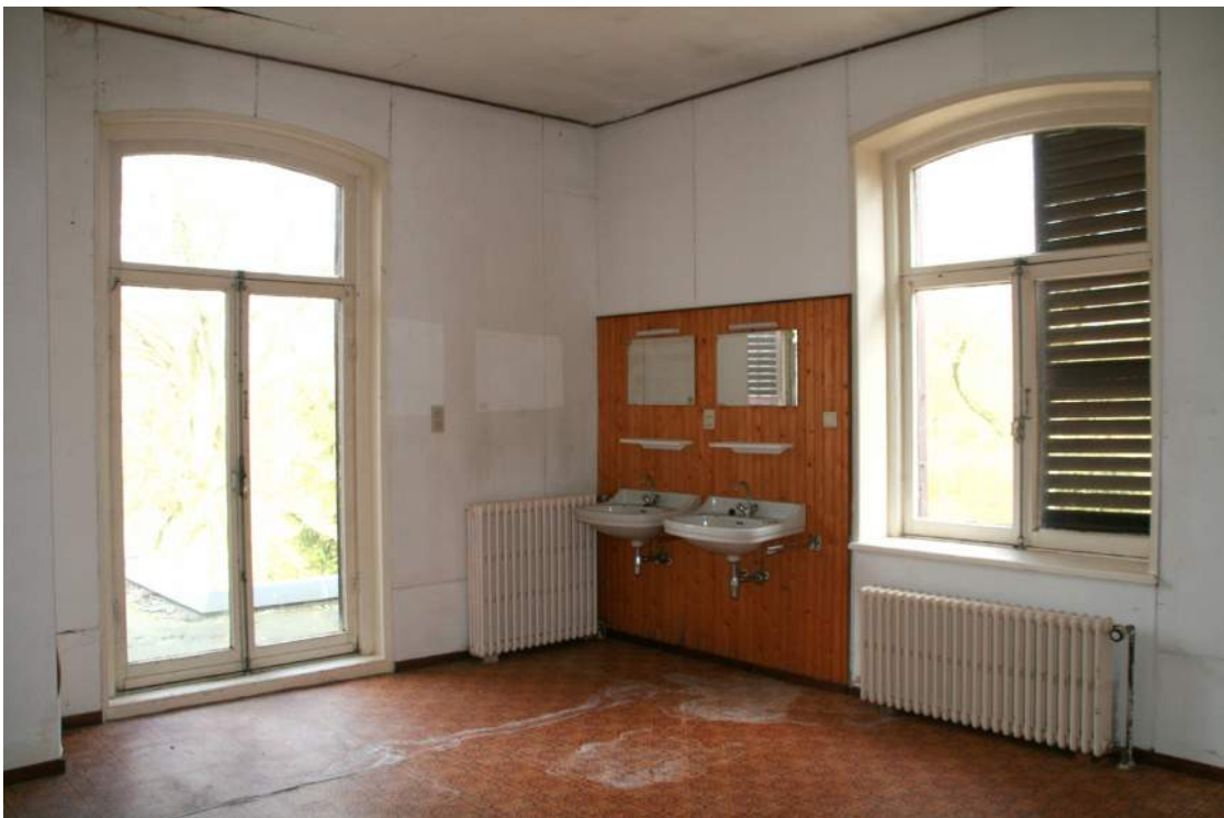
Afb. 46 Ruimte 1.04, gezien naar het noordoosten.
