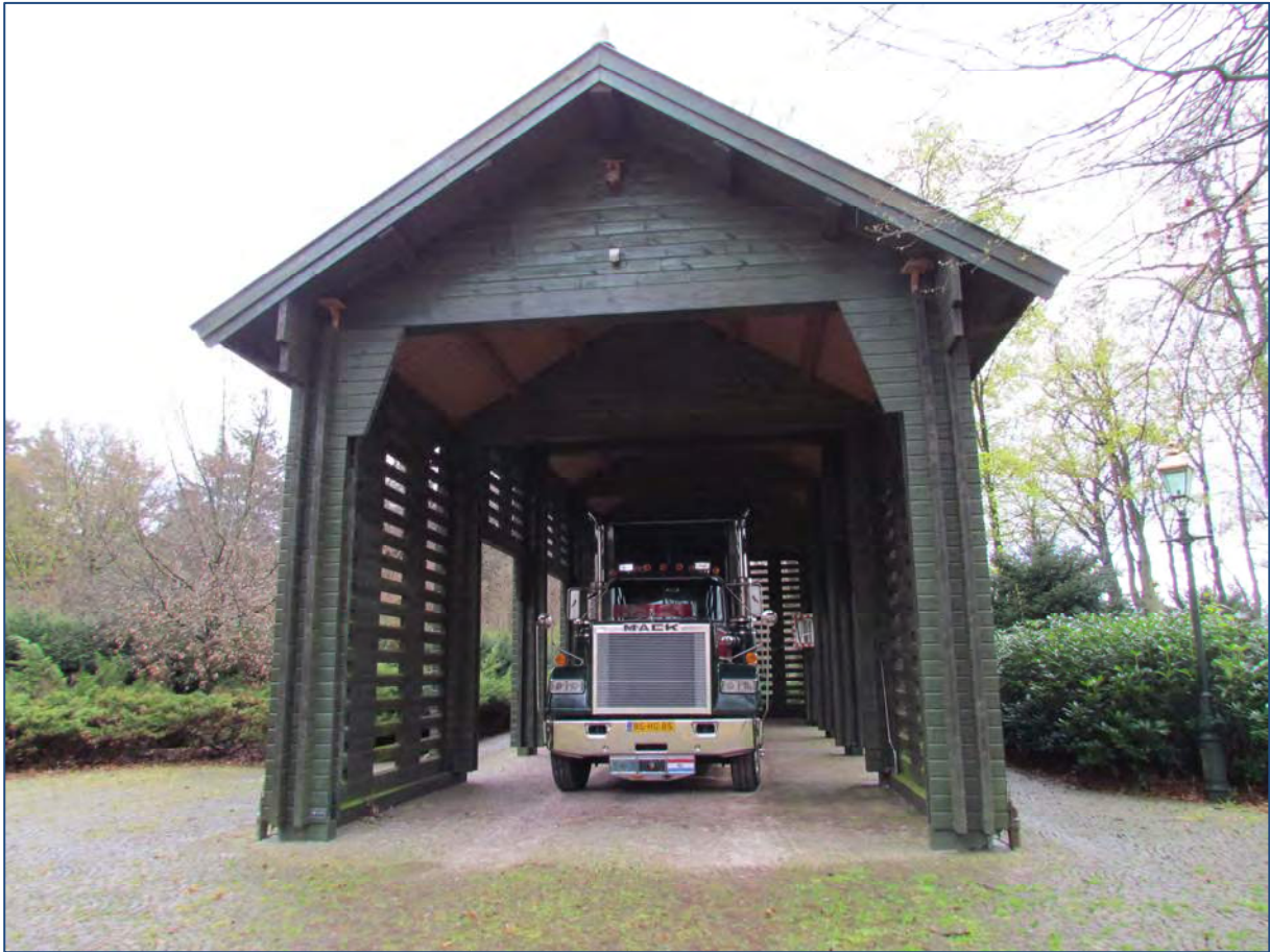
De houten schuur wordt gebruikt als en heeft de constructie van een grote carport (HV)
