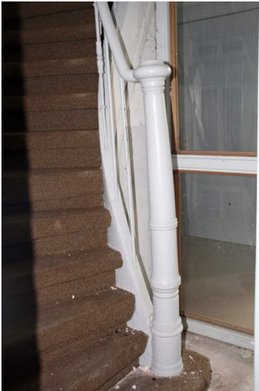
Afb. 45 De trappaal van de trap (0.11) naar de eerste verdieping.
