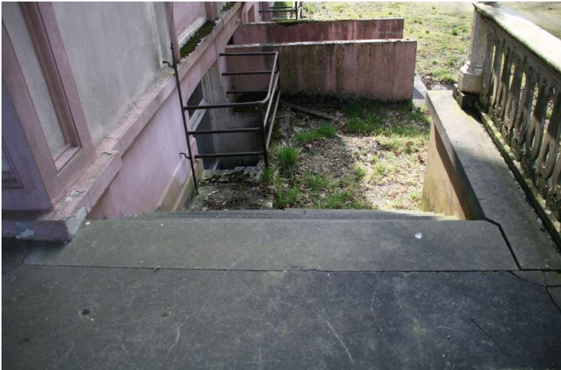
Afb. 24 Westelijke trap naar de veranda. De vloer van de veranda bestaat uit Portlandcement, terwijl de traptreden van hardsteen zijn.
