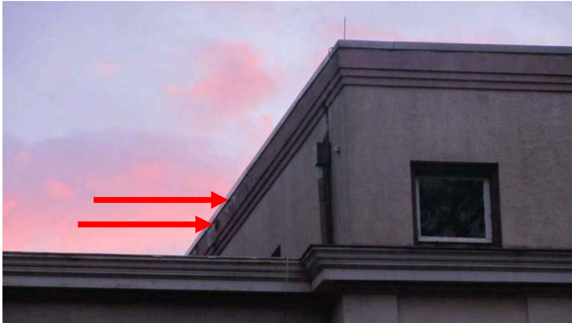
Verblijfplaats 4, van meer dan tien gewone dwergvleermuizen onder metalen daktrim aan westzijde bovenste, latere opbouw
