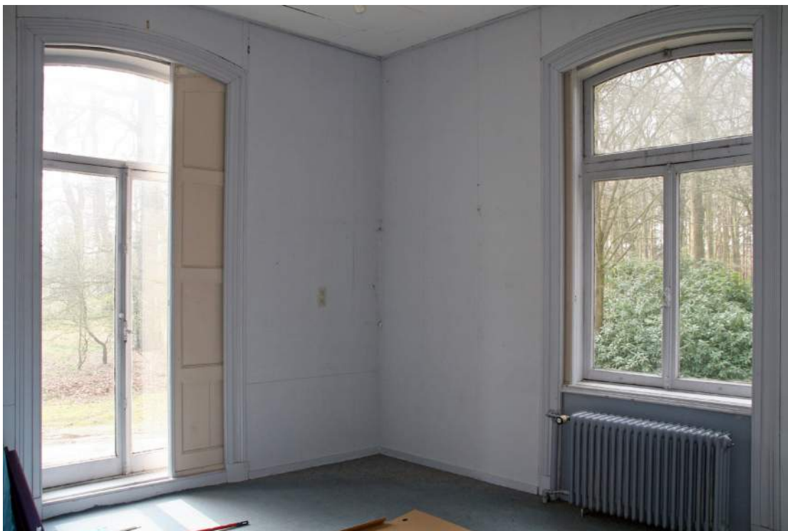
Afb. 40 Ruimte 0.07, gezien naar het zuidwesten. Dit was oorspronkelijk waarschijnlijk de eetkamer. De openslaande deuren, voorzien van schuifblinden, hadden oorspronkelijk een Frans balkon.
