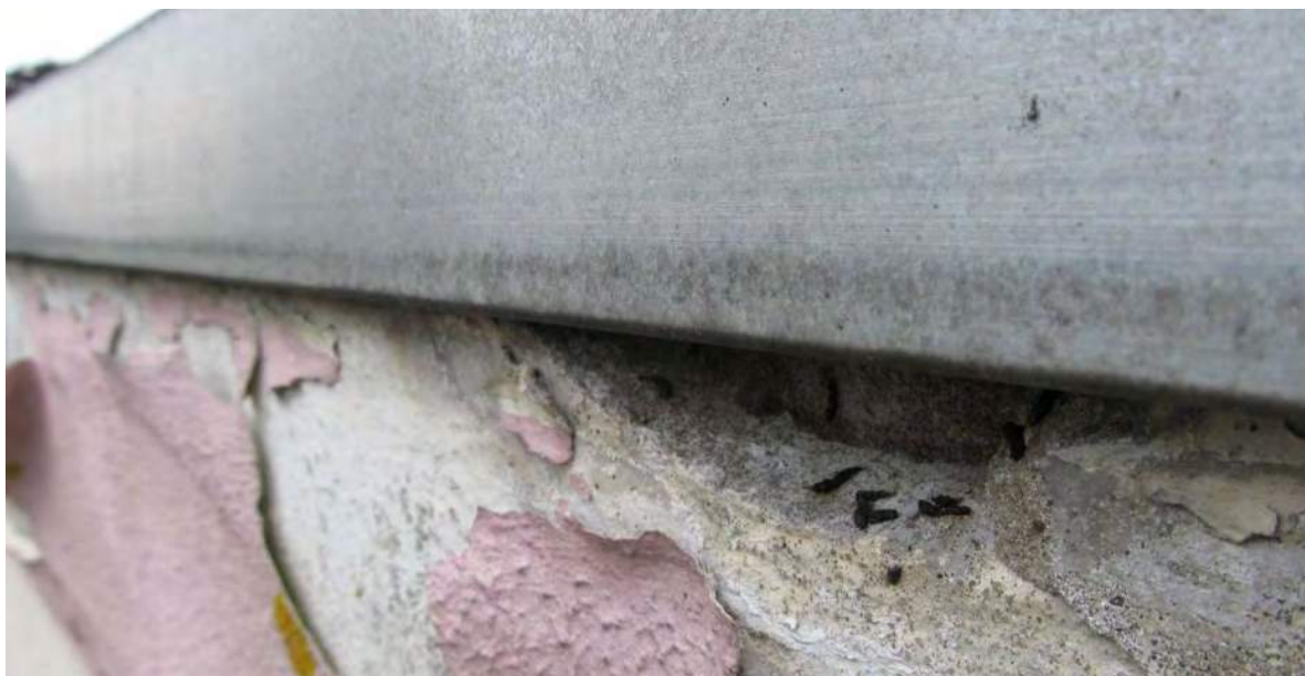
Eén van de inkruipopeningen met verse keutels van gewone dwergvleermuizen onder metalen daktrim aan westzijde latere opbouw
