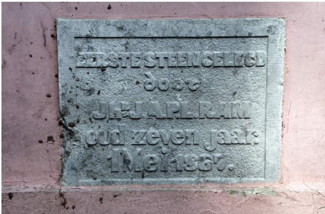
Afb. 20 De eerste steen, gelegd op 1 mei 1865 door jhr. J.A.P.M. Ram, een zevenjarige neef van de eigenaar jhr. J.P.A.L. Ram. De steen is ingemetseld in de oostelijke travée van de voorgevel.
