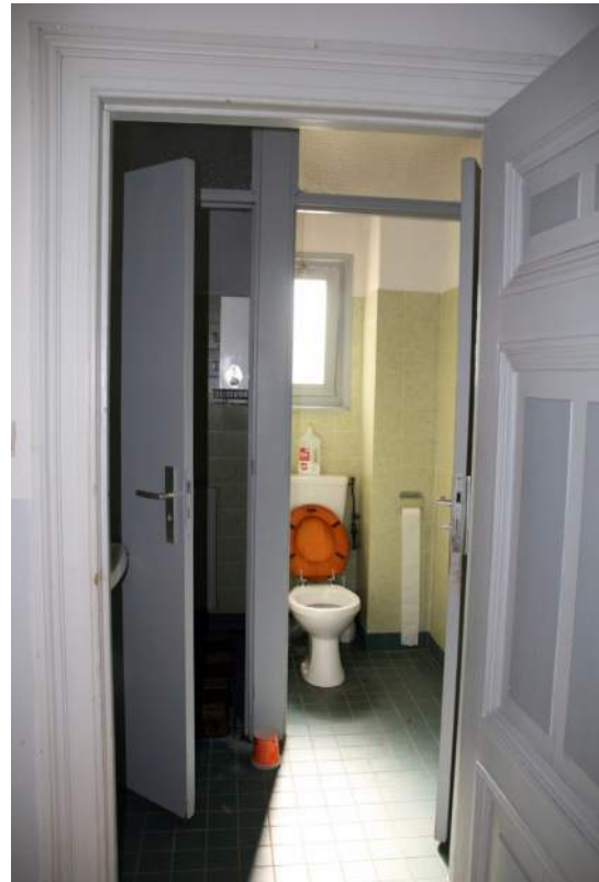
Afb. 43 Ruimte 0.10, gezien naar het zuiden. De indeling met een wc- en een doucheruimte met voorportaalje dateert vermoedelijk uit de fase 1975; het raam is hierbij aangepast.
