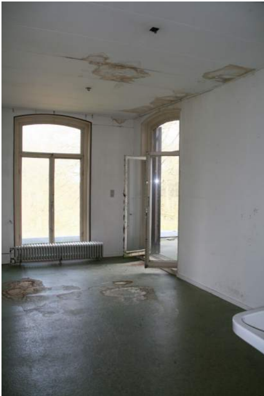
Afb. 48 Ruimte 1.05a, gezien naar het noordoosten. Rechts de openslaande deuren naar het balkon op de veranda.
