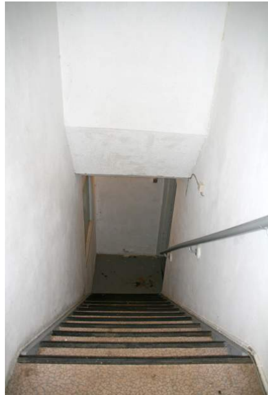
Afb. 41 Ruimte 0.08, met trap van bel-etage naar souterrain.
