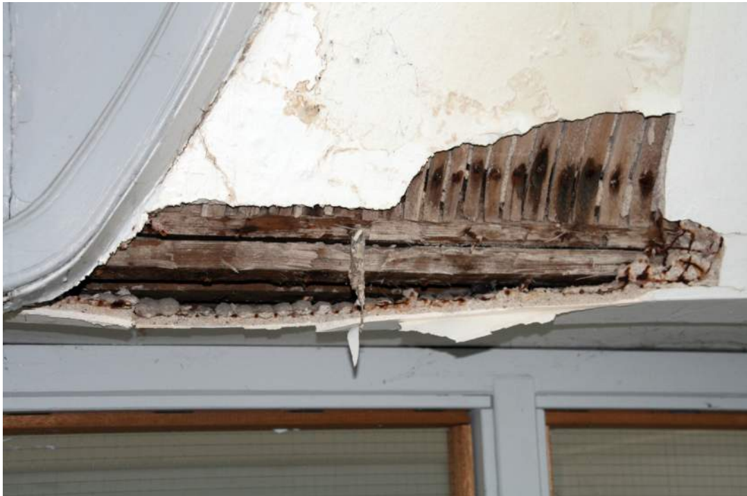
Afb. 37 Detail van het stucplafond in de hal, gezien vanaf de trap naar de eerste verdieping. Te zien is dat hier ook stuc op steengaas is toegepast.
