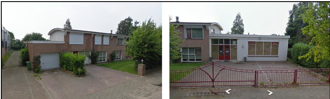
Afbeelding 5: Foto's bestaande situatie.
