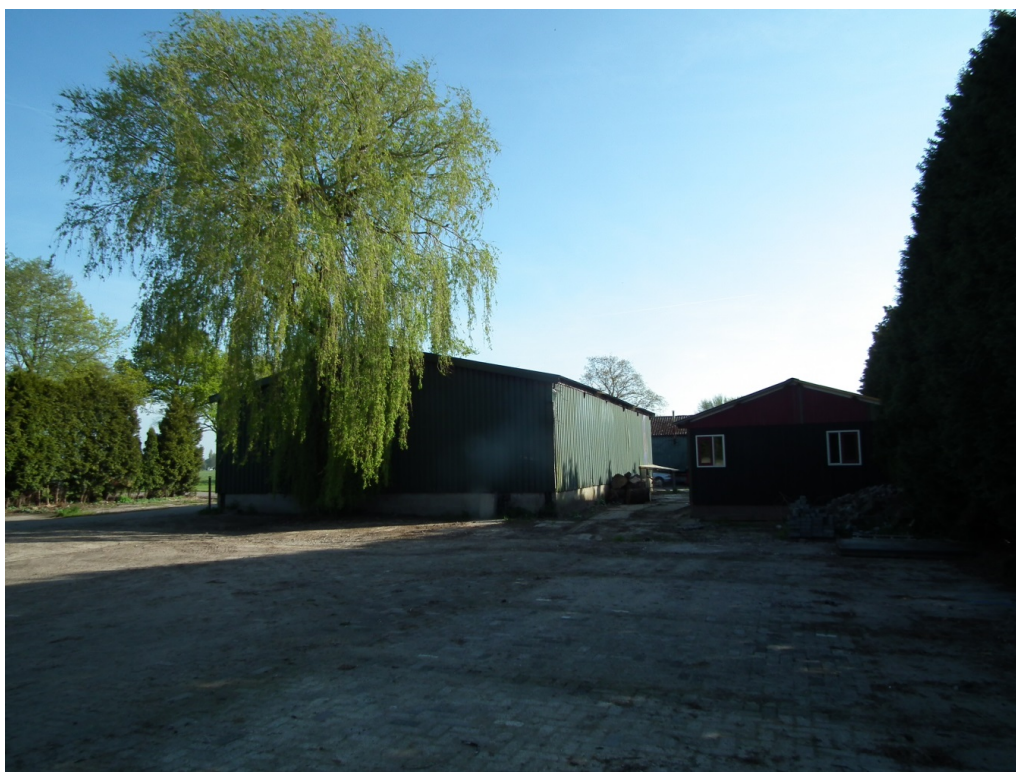
Figuur 3 Men is voornemens een varkensstal en een drietal schuurdelen te slopen.
