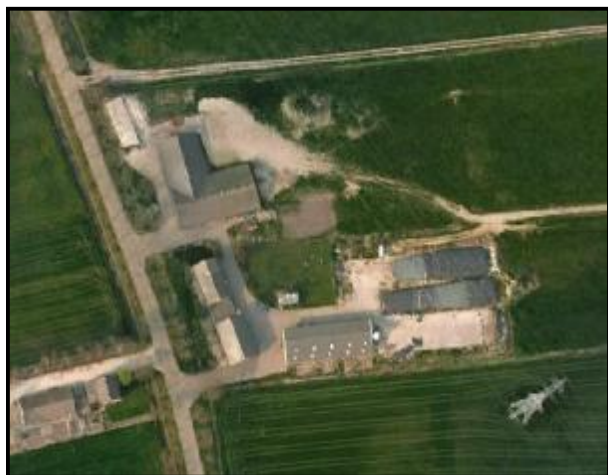
Luchtfoto van Maatsteeg 16
