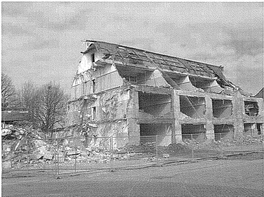
Figuur 3: voorbeeld van een gebouw waarbij eerst het buitenblad is verwijderd.
