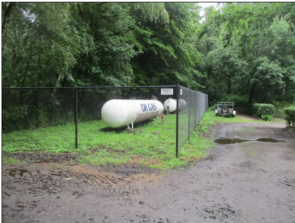
Figuur 2 De te verplaatsen gastanks.
