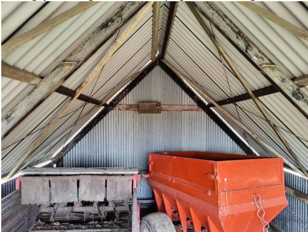
Afbeelding 5. Kerkuilenkast binnen de kapschuur (noordkant).
