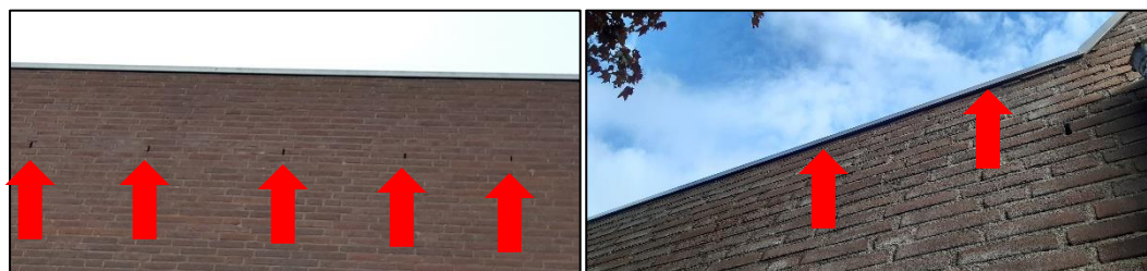
Afbeelding 5: Openingen in het gebouw in het plangebied (rode pijlen), met name open stootvoegen (links) en onder de dakoverstekken (rechts) die gebouwbewonende vleermuissoorten toegang naar geschikte ruimtes bieden (Foto's: Laneco, 2022).
