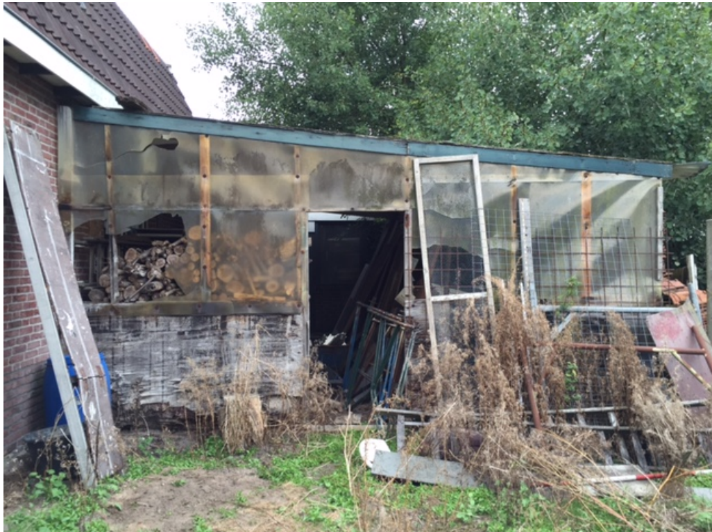
Figuur 3 Ten oosten van de werkplaats is een noodschuur gesitueerd. De noodschuur wordt ook gesloopt.
