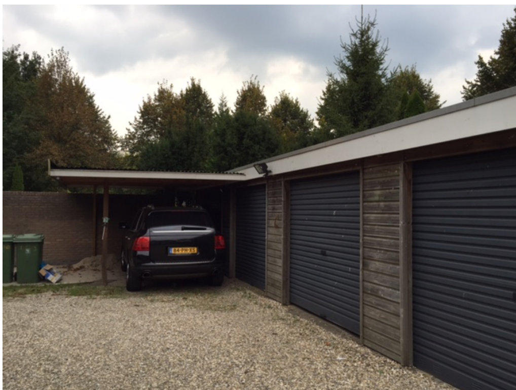
Figuur 2 De carport en garages worden gesloopt ten behoeve van de te realiseren woning
