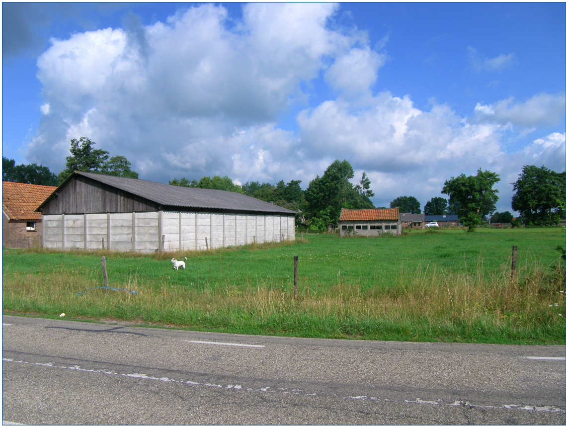
Figuur 2. Het plangebied aan de kruising van de Weteringsteeg en de Friesesteeg in Achterberg.
