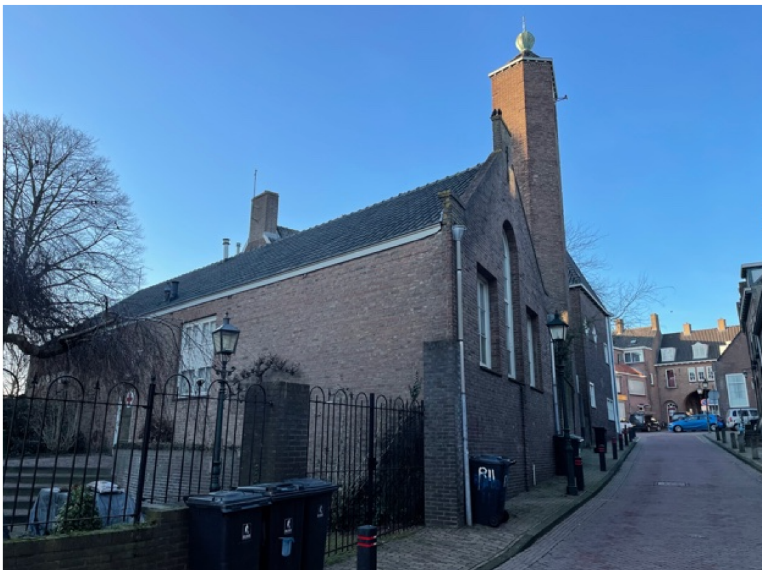
Fig. 3.4 Zuidzijde pand (met het 'Rode Kruis gebouw')
