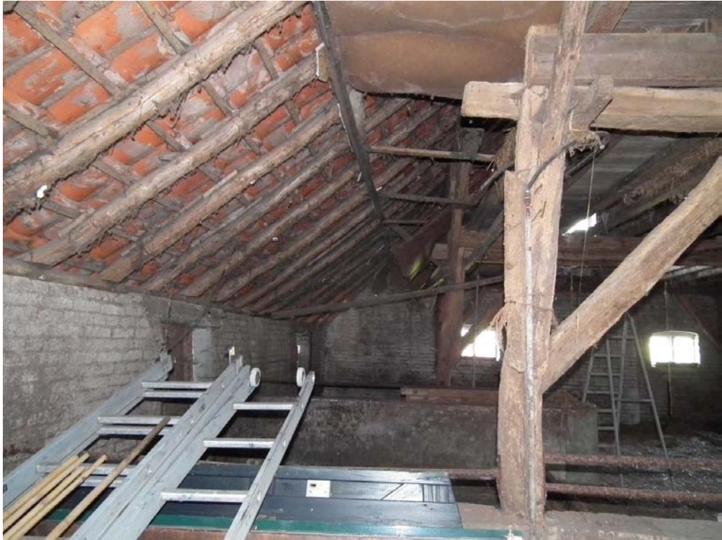
Figuur 3 De te slopen bebouwing is dermate open aan zowel de binnenzijde, buitenzijde als openingen en holtes dat nestlocaties en verblijfplaatsen niet verwacht worden.
