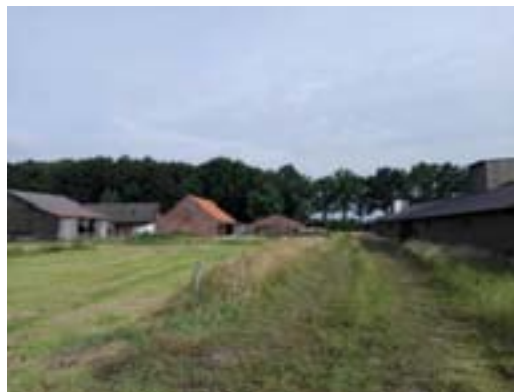
Zicht achter op het erf: te slopen bebouwing
