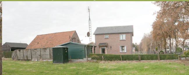
Schuttingen en niet-streekeigen beplanting doen afbreuk aan het buitengebied en aan het agrarische karakter van het landschap.
