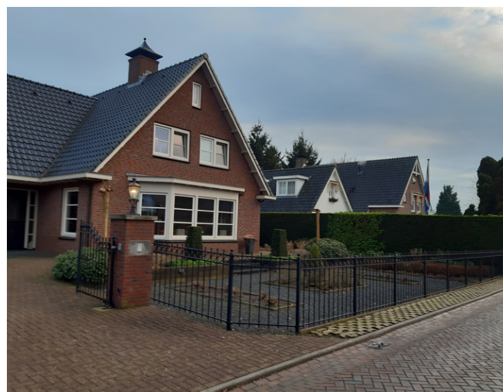
» Overzicht van bestaande bebouwing aan de Vissersweg
