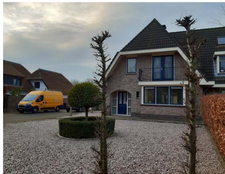
» Overzicht van bestaande bebouwing aan de Vissersweg
