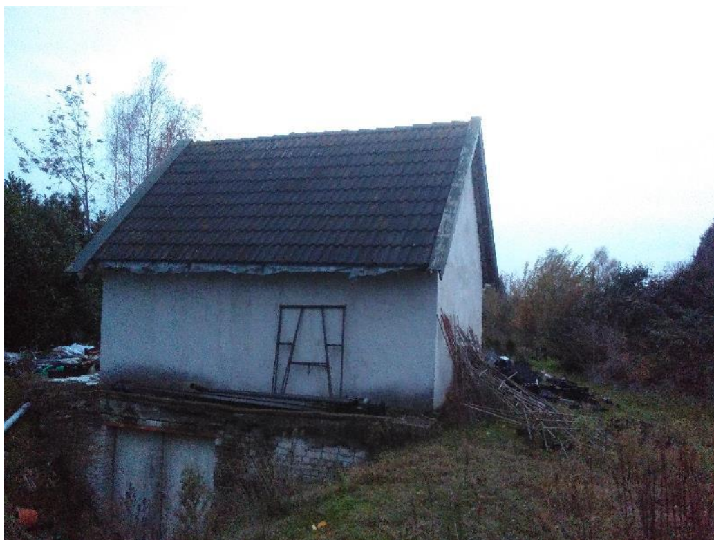
Figuur 2 Het schuurtje is wat meer achterop het perceel gelegen en is opgetrokken uit grote betonnen stenen muren en een zadeldak met dakpannen.
