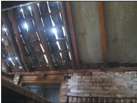
Foto 3. Geen dakbeschot en spouwmuur en veel lichtinval op zolder bedrijfsgebouw (zijde Hofstraat).
