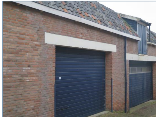
Foto 2. Gevels van het te slopen bedrijfsgebouw (zijde Hofstraat): geen beschermde muurplanten, als de matig beschermde tongvaren, aanwezig.
