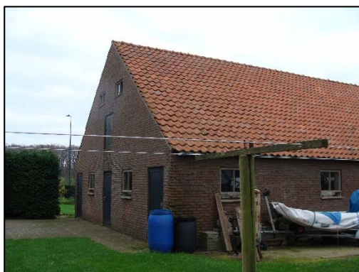
Foto 1. Te slopen stenen schuur
