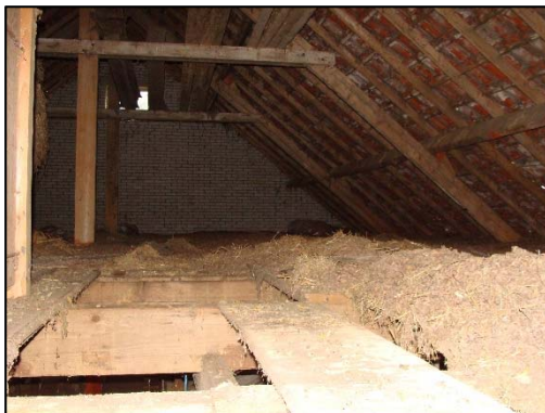
Foto 5. Zolder stenen schuur
