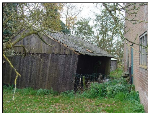
Foto 2. Te slopen houten schuur
