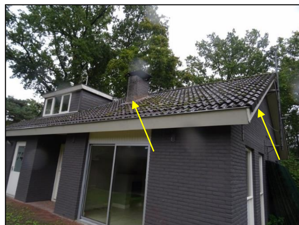
Figuur 12. Lodge met overhangende kantpannen en loodflabben is geschikt voor vleermuizen.
