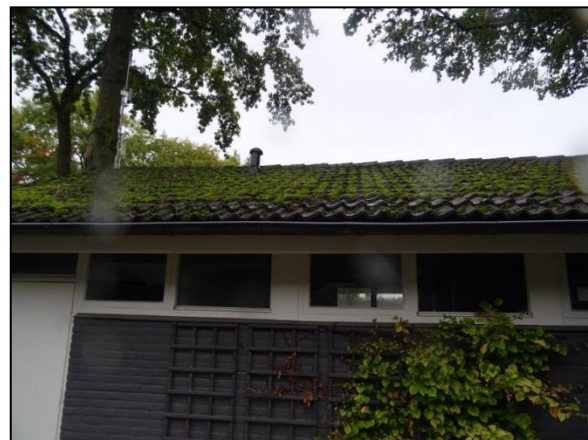
Figuur 11. Lodge gedekt met dakpannen.
