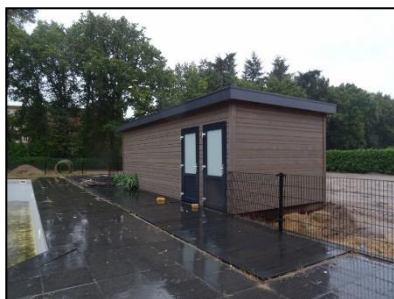
Figuur 7. Technische ruimte voor het buitenzwembad.
