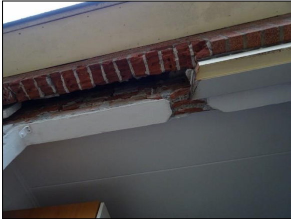
Figuur 13. Raamkozijnen zijn verwijderd uit de receptie.
