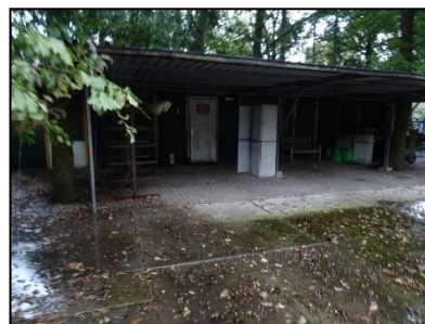
Figuur 8. Opslagschuur ten noordoosten van de onderzoekslocatie.
