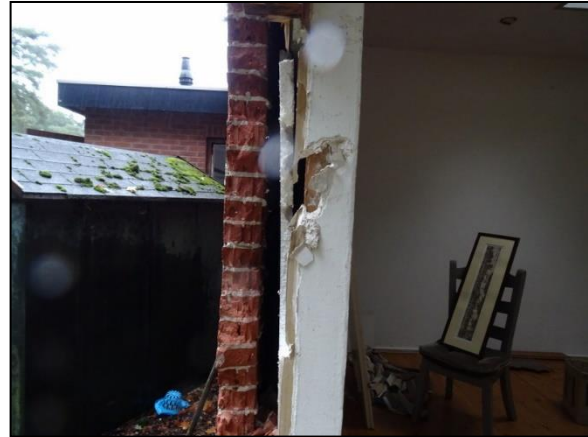
Figuur 14. Luchtspouw van receptie staat onder invloed van vocht en tocht.
