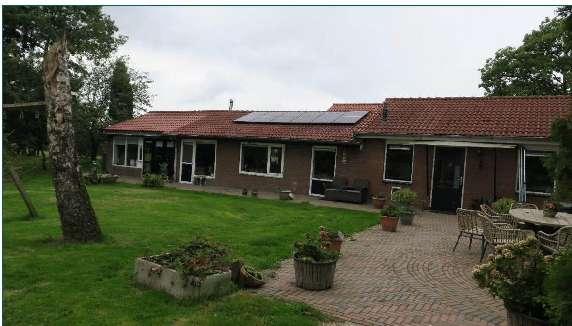
Figuur 2 De rijtjeswoningen bestaan uit gemetselde muren met spouw en zijn voorzien van een zadeldak met dakpannen.
