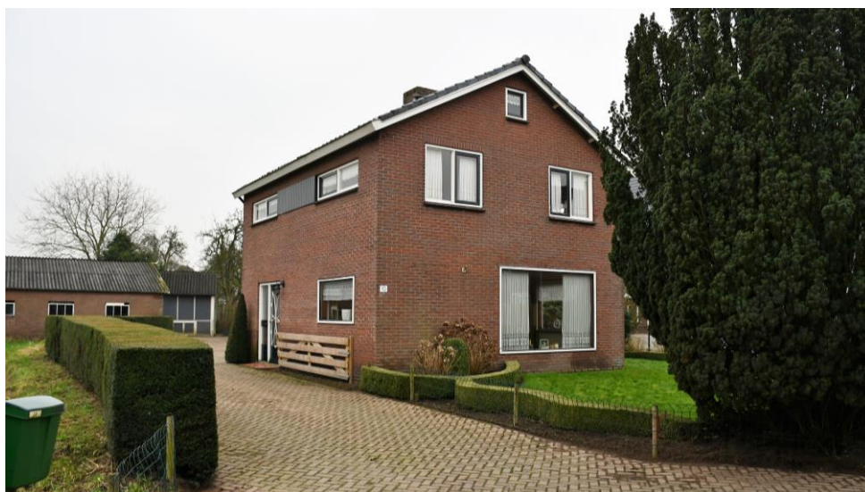
Foto: vooraanzicht bestaande woning Korte Steeg 10
