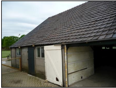
Figuur 4. Schuur 1A
