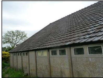
Figuur 5. Achterzijde schuur 1A
