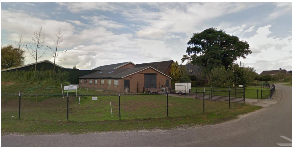
Zicht op bestaande locatie Hogesteeg 21 (bron: GoogleStreetview)
