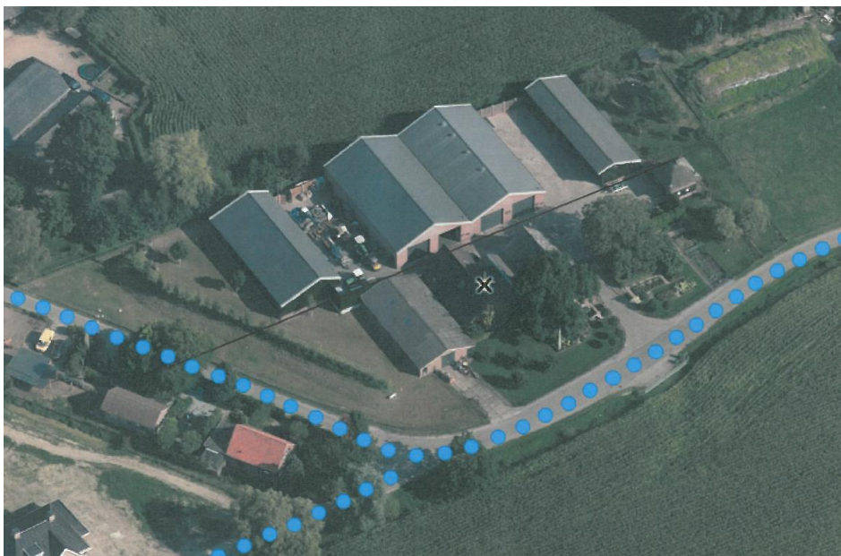
Zicht van bovenaf op het bestaande bedrijf
