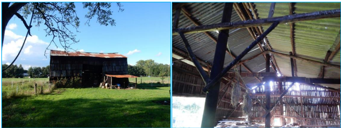
Foto's: Indrukken deelgebied Cuneraweg. De te amoveren opstallen.
