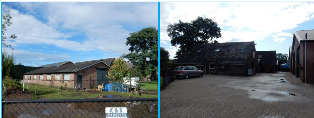
Foto's: Indrukken deelgebied Hogesteeg. De te amoveren opstallen.
