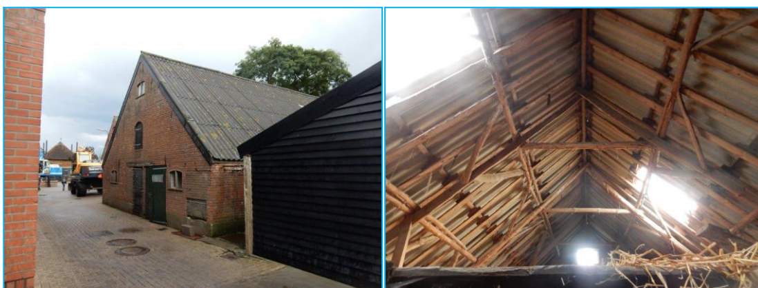
Foto's: Indrukken deelgebied Hogesteeg. De te amoveren opstallen.
