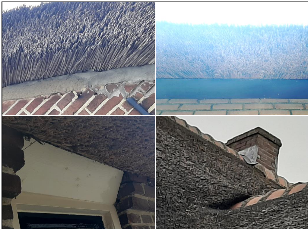
Figuur 4 Detailfoto's van de daklijst, aansluiting van kozijnen in de gevels en de dakbedekking. Voor alle structuren geldt dat de aansluiting dermate goed is dat er geen kieren aanwezig zijn die potentieel geschikt zijn voor vleermuizen als verblijfplaats.
