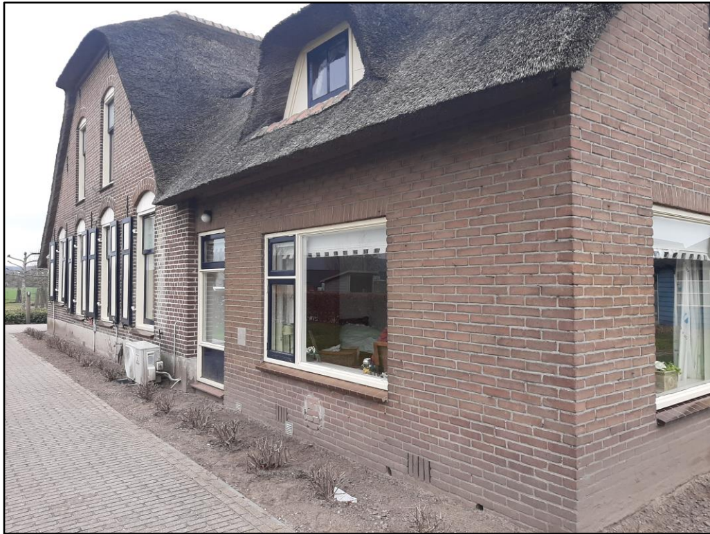
Figuur 5 Ventilatie rooster bevinden zich net boven de grond, waardoor deze ongeschikt zijn als invliegopening voor vleermuizen.
