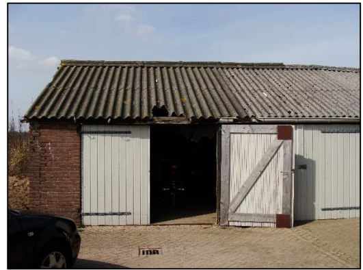
Foto 2. Te slopen schuur in het noorden van het plangebied
