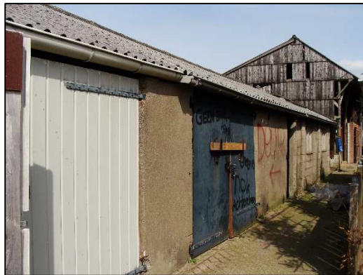
Foto 3. Te slopen schuur
