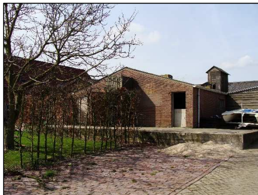
Foto 5. Voorzijde te slopen voormalige stal
