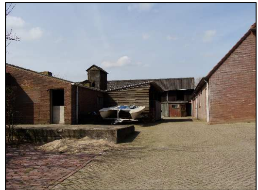
Foto 4. Links te slopen stal, rechts te behouden schuur
