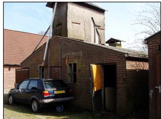
Foto 6. achterzijde te slopen stal
