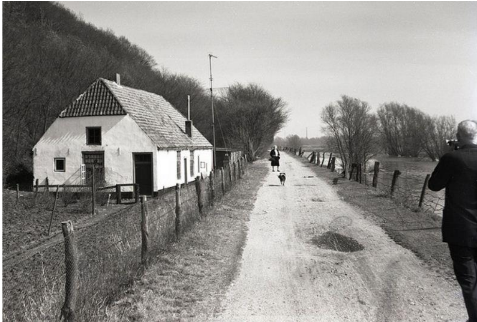
Fig. 2.6. De Cuneralaan in 1964, ten oosten van het plangebied, gezien richting Wageningen (het oosten). ( http://www.flickr.com/photos/rienkmebius/2551171339/ ).
