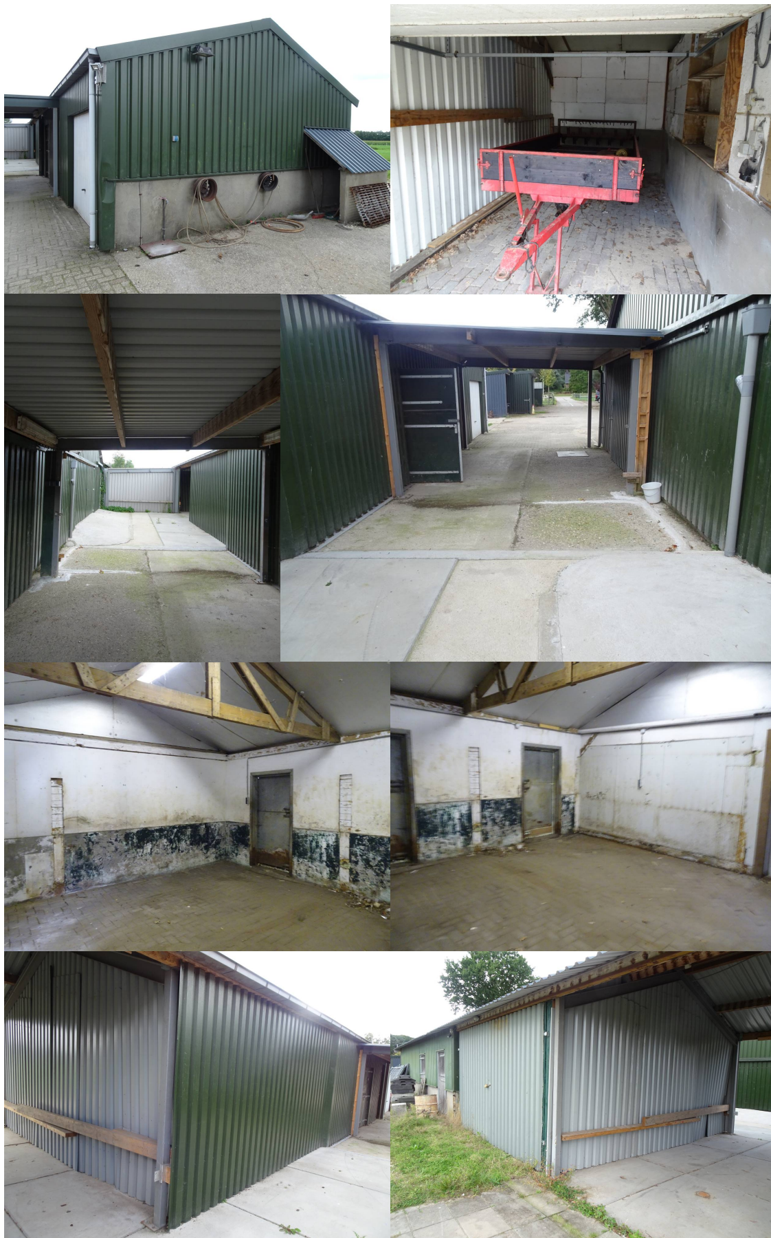
Vervolg figuur 2. Foto- impressie van te slopen loodsen aan Cuneraweg 266 te Rhenen.
