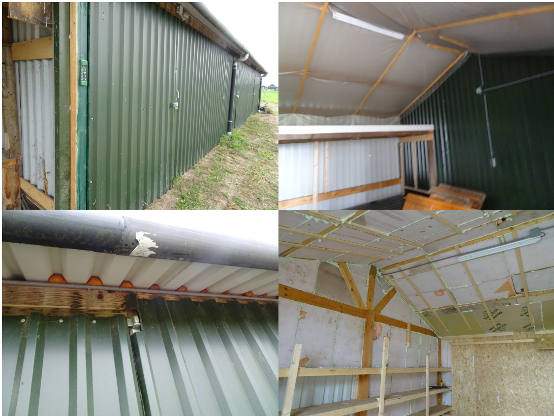
Vervolg figuur 2. Foto- impressie van te slopen loodsen aan Cuneraweg 266 te Rhenen.
