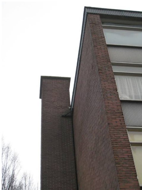
Foto 6: Tussen de schoorsteen en de gevel van de flat zit een in potentie zeer geschikte verblijfplaats voor vleermuizen (spleet van enkele centimeters)
