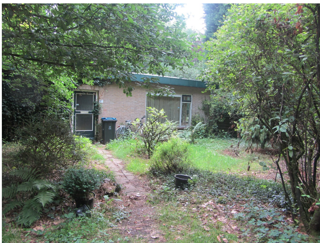
Figuur 2 De planlocatie betreft een woning gelegen in het bos van Nationaal Park Utrechtse Heuvelrug. De woning wordt gesloopt ten bate van de realisatie van een nieuw woonhuis aan Autoweg 1 te Rhenen.
