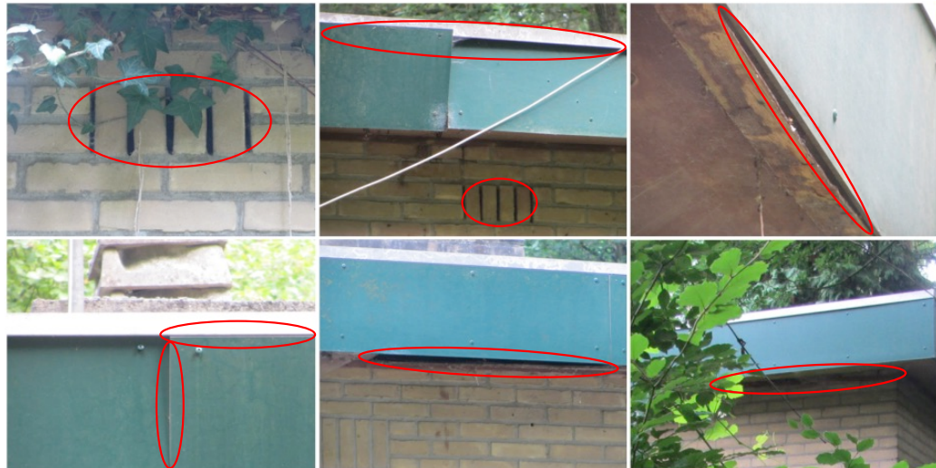
Figuur 2 In het woonhuis aan de Oude Veensegrindweg 37 te Rhenen zijn diverse potentiële vaste rust- en/of verblijfplaatsen voor vleermuizen aangetroffen.
