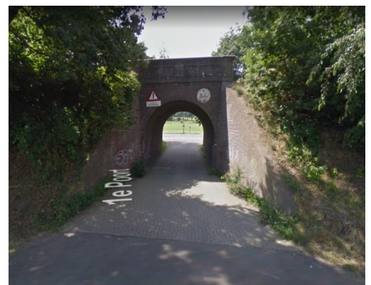
Figuur 9 Fietstunnel onder spoordijk (Bron: Google Maps)
