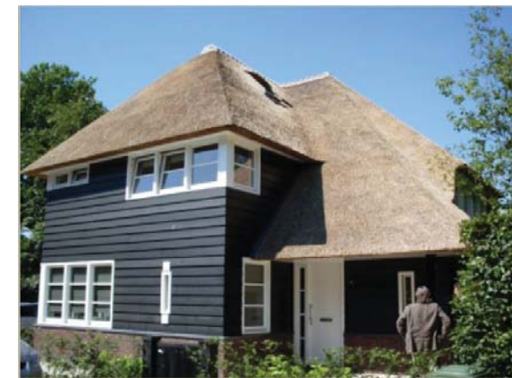
Gepotdekselde gevel
