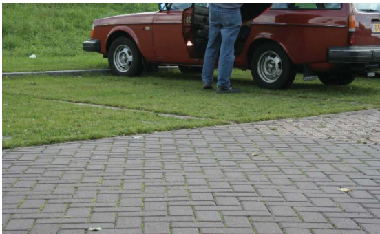
Parkeren op grasbeton
