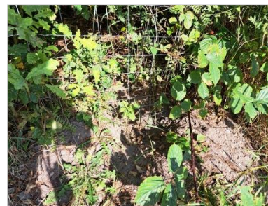
Figuur 4.6 onderdoorgang in hekwerk.
