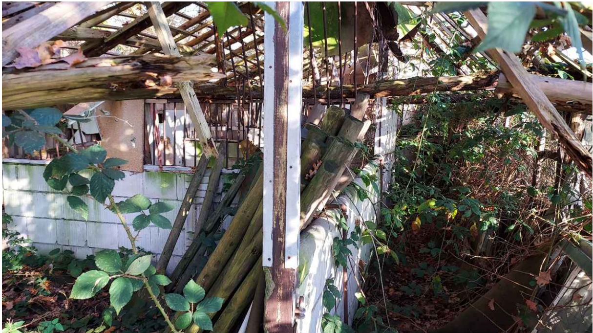
Figuur 17. Gebouw H Paardenstal (te slopen)
