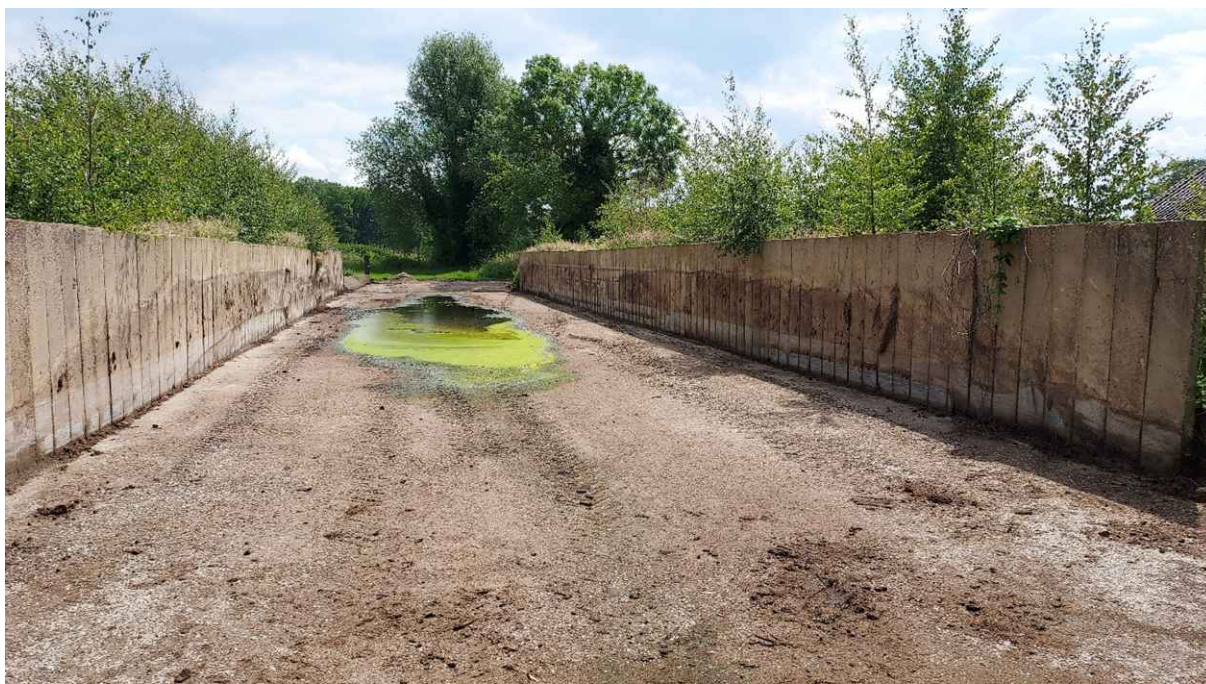
Figuur 12. Bouwwerk F: oostelijke gleuvsilo (te verwijderen)
