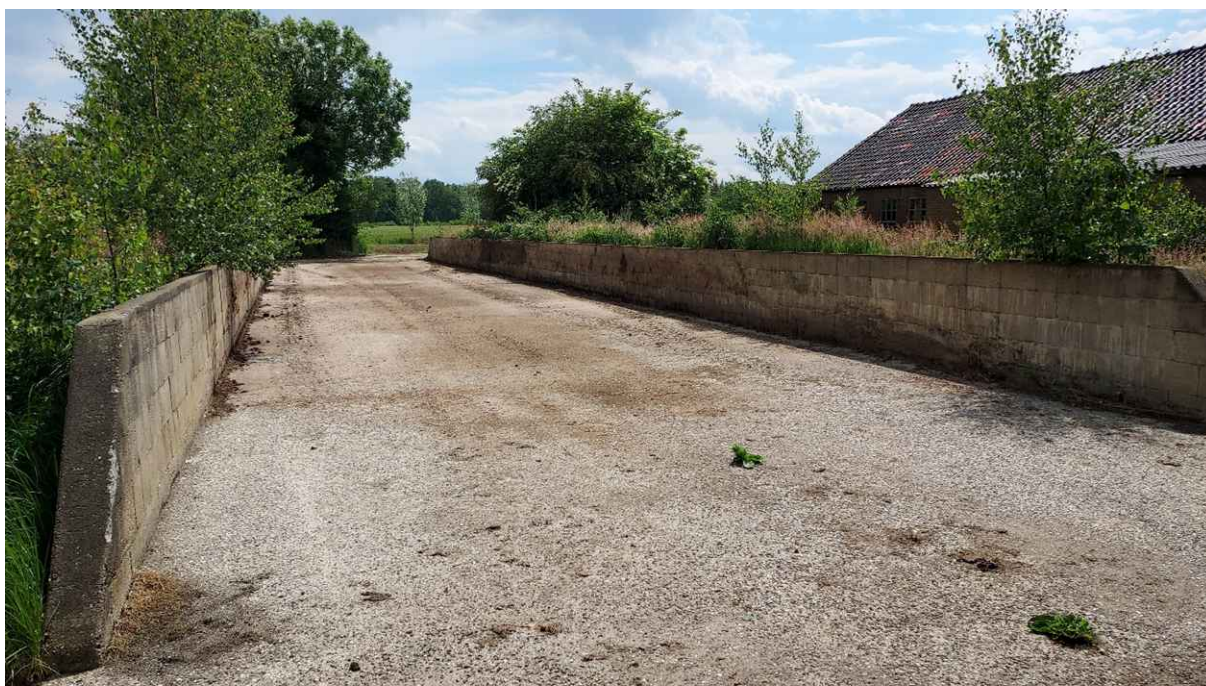
Figuur 13. Bouwwerk F: westelijke gleuvsilo (te verwijderen)
