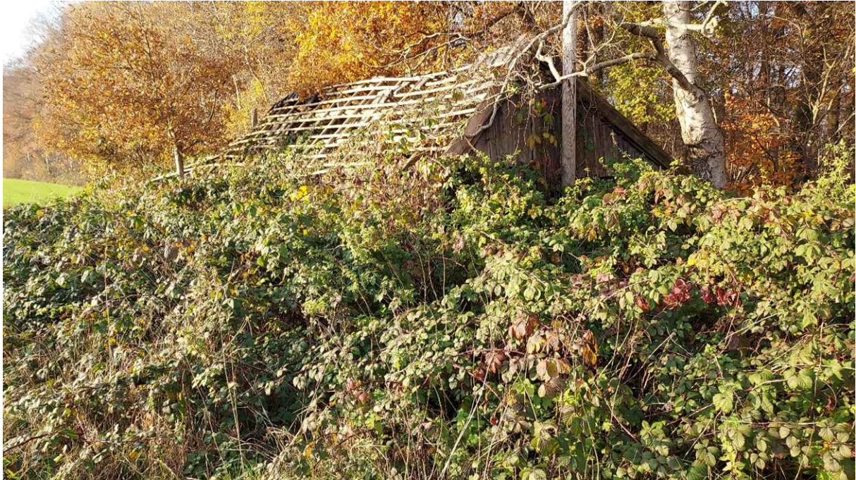
Figuur 16. Gebouw H Paardenstal (te slopen)
