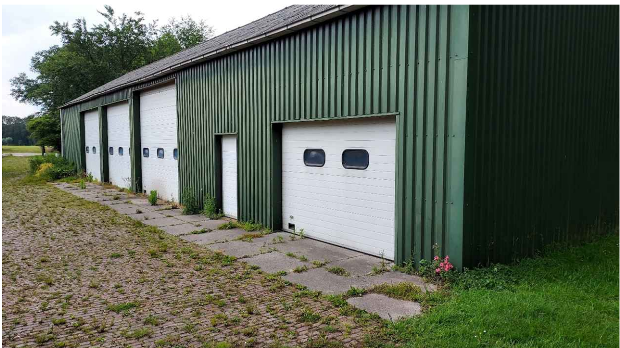
Figuur 10. Gebouw D: Wagenloods (te slopen)
