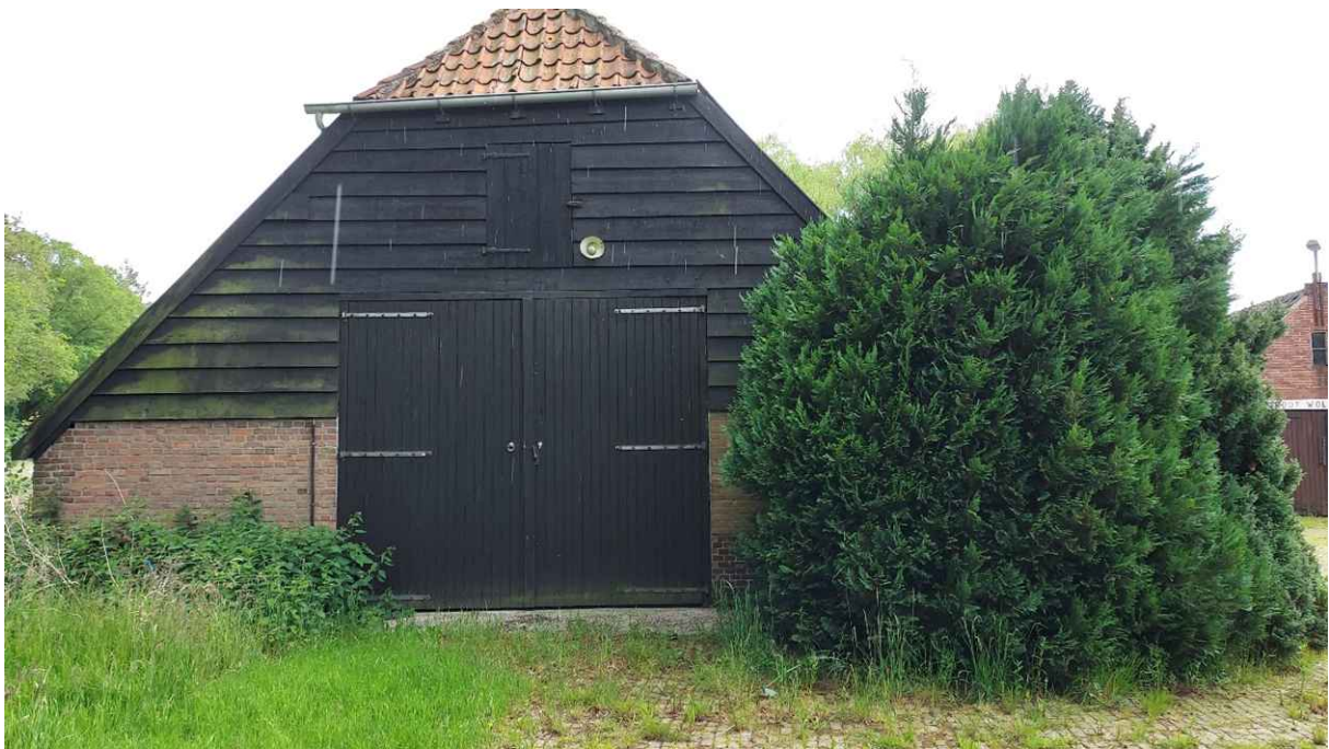
Figuur 9. Gebouw C: stal (te slopen)
