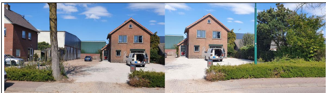
Afbeelding 7: Foto's bestaande situatie.
