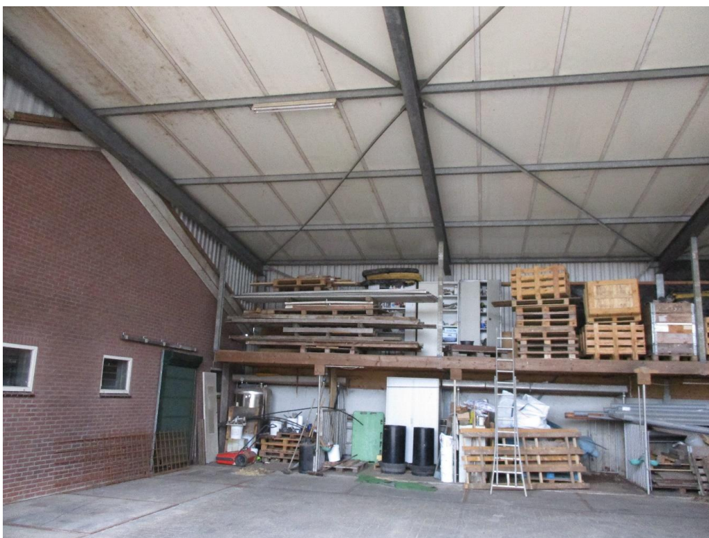
Figuur 2 Binnenzijde van de overkapping, links is één van de stallen zichtbaar. In de overkappingen zijn geen sporen van uilen aangetroffen.
