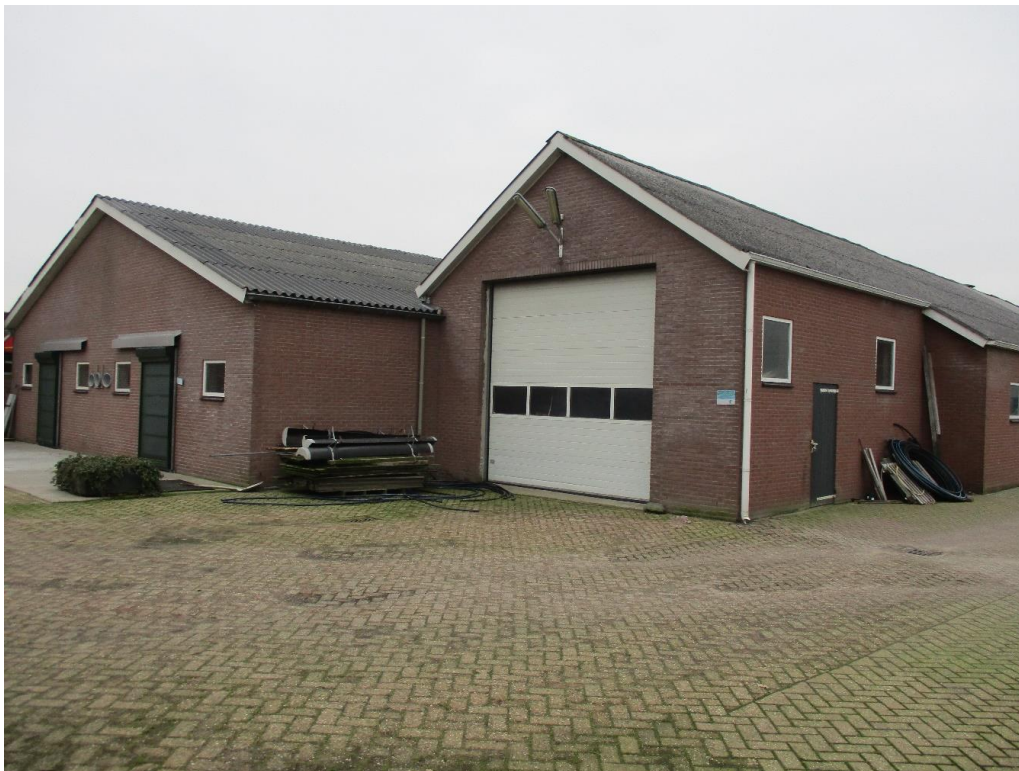
Figuur 1 De planlocatie is gelegen aan de Utrechtseweg 24 te Renswoude en bestaat uit twee (voormalige)stallen opgetrokken uit gemetselde muren zonder spouw en zadeldak met golfplaten en een overkapping.
