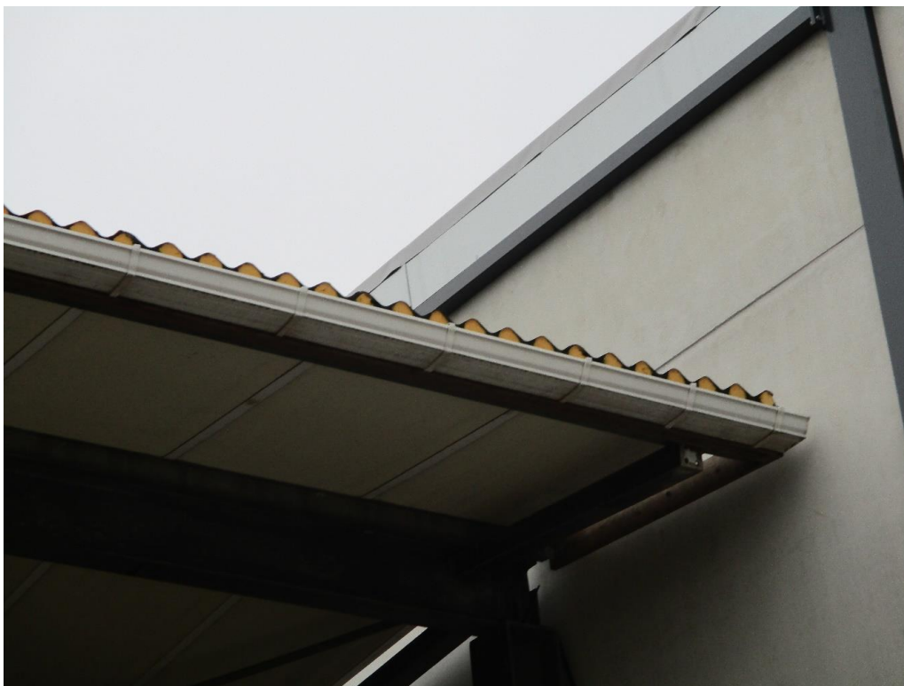
Figuur 3 Het dak van de overkapping is ontoegankelijk gemaakt voor huismussen.
