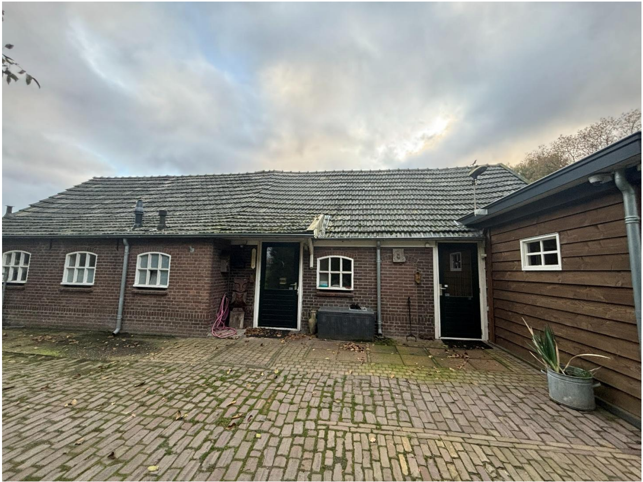
Overzicht foto Oude Vakenschuur
