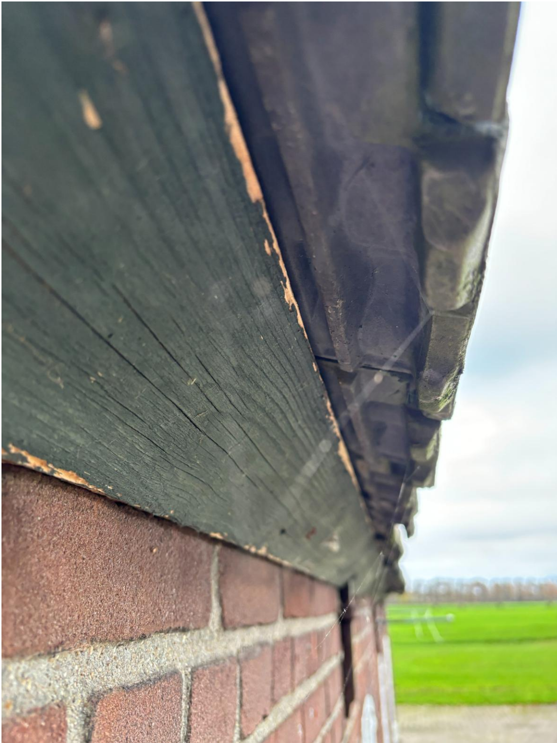
Geen opening onder dakpannen en zijkant
