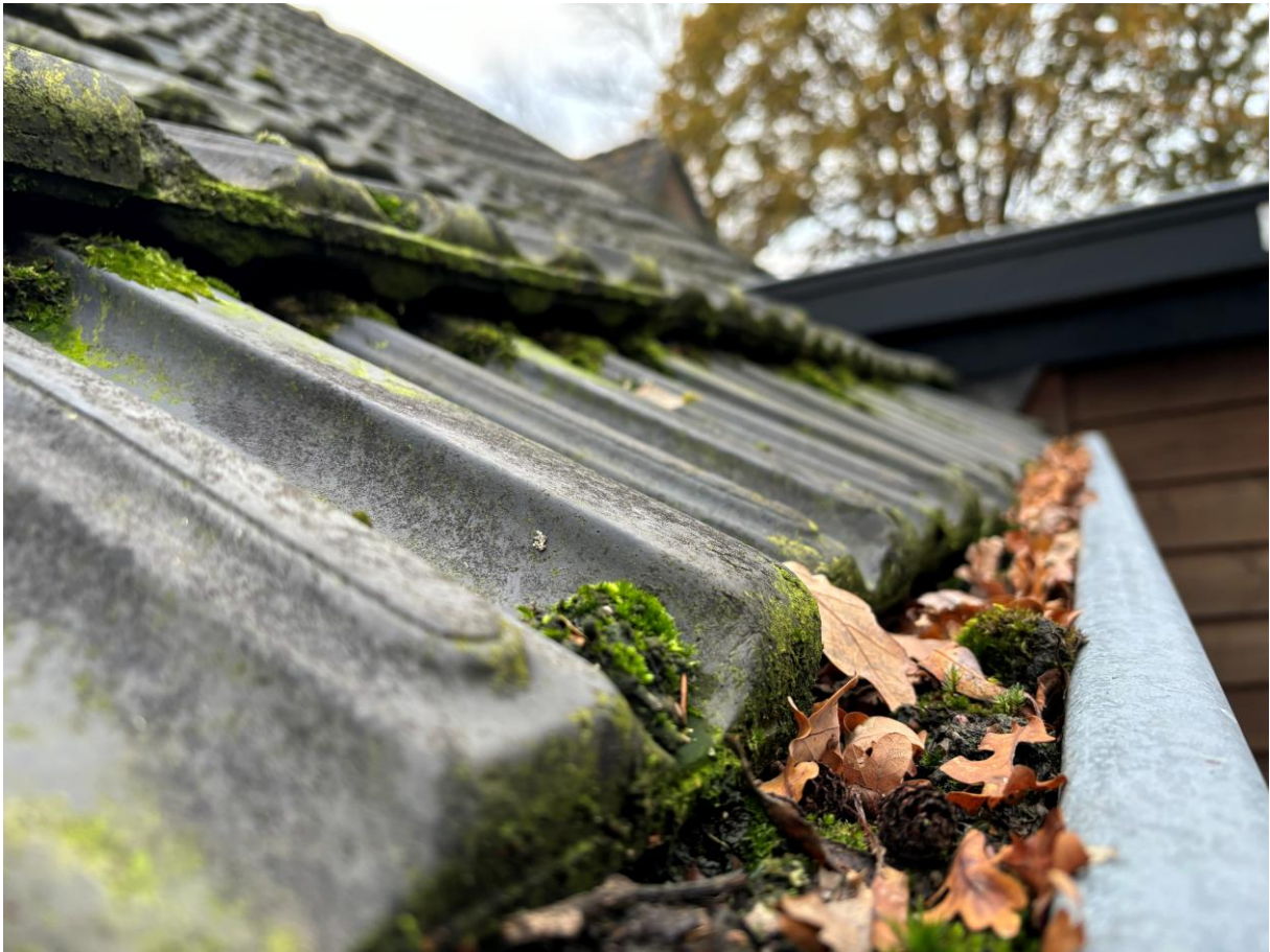
Dakgoten dicht
