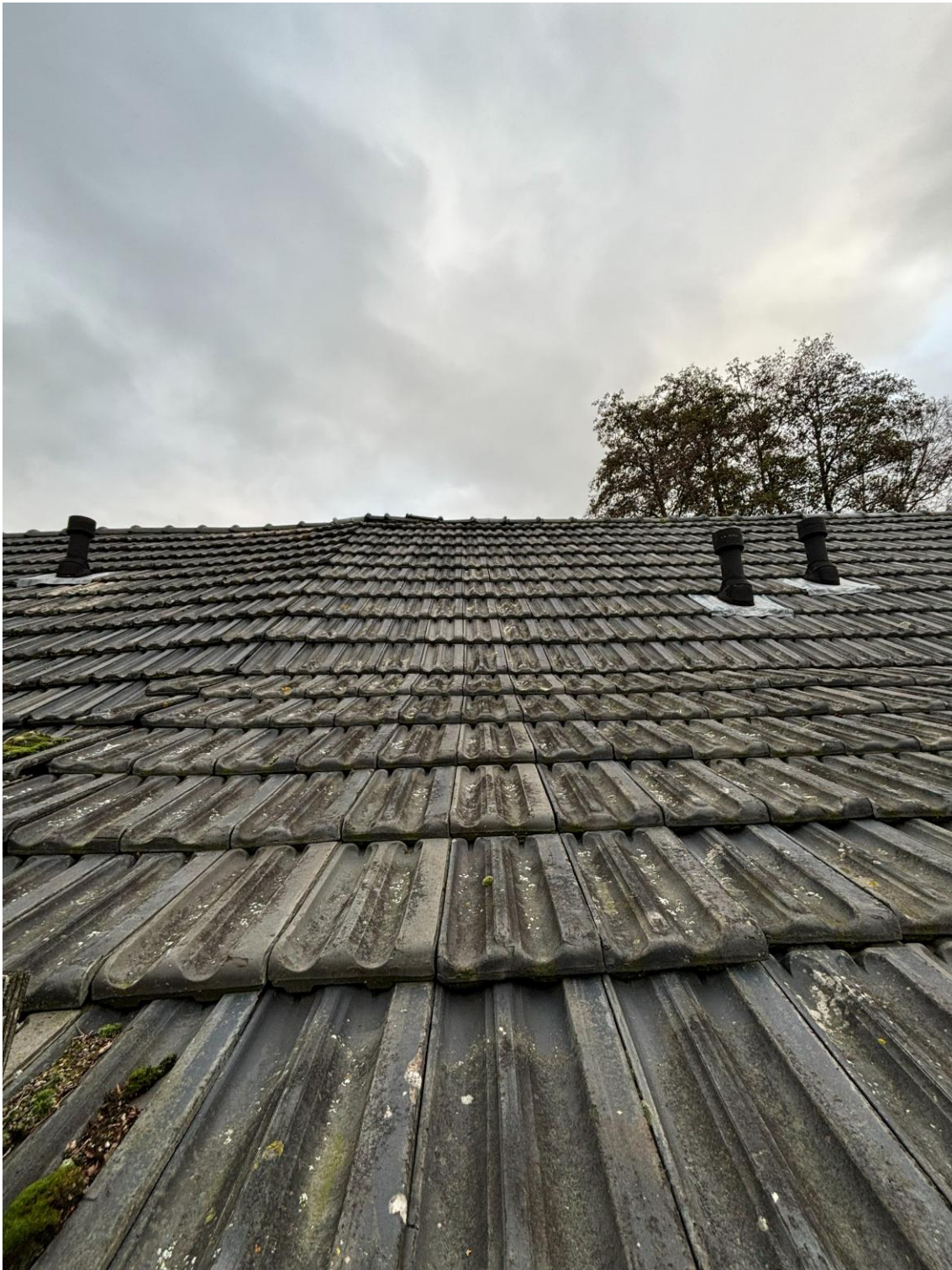
Gesloten dakpannen sluiten aan doormiddel van nok onderzijde pan en gemetselde nokpakken
