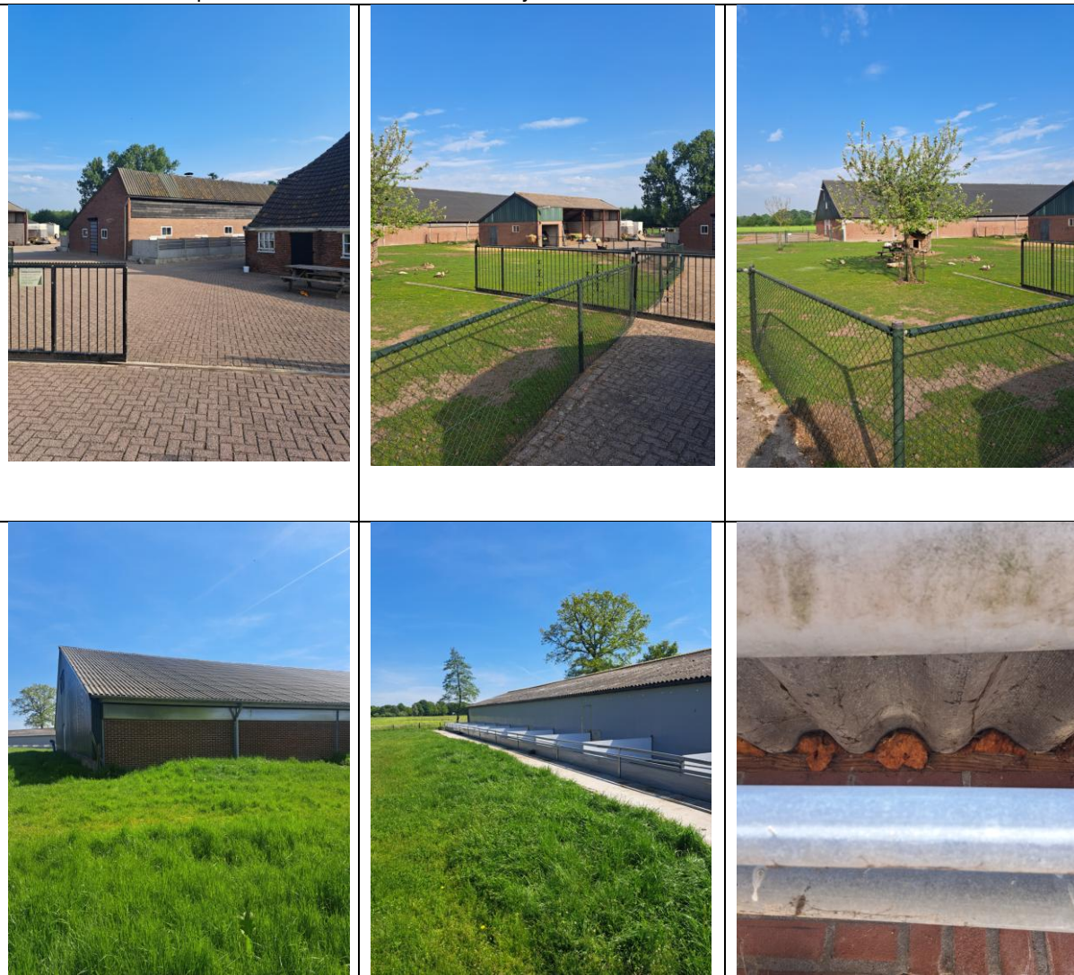
Foto's van de te slopen stallen vanuit verschillende zijdes
