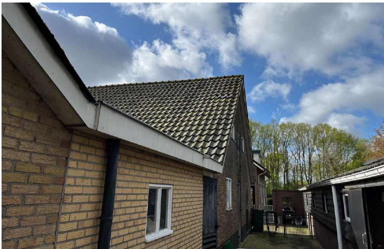
Gebouwen (midden op het erf) die gesloopt gaat worden, met op de achtergrond de bestaande woning
