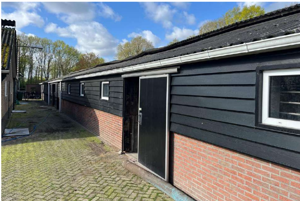
Een van de gebouwen (aan de westkant van het erf) die gesloopt gaat worden
