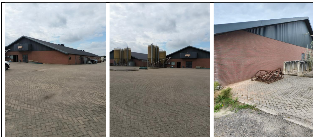
De te slopen stallen gezien vanaf de voorzijde-beide stallen hebben dezelfde bouwstijl.
