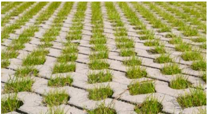
parkeren uitvoeren met grasbetonkei
