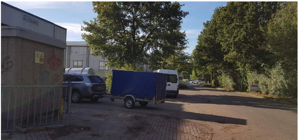
Afbeelding: Zicht op huidige bebouwing met te slopen bebouwing (bovenste foto en onderste op voorgrond)
