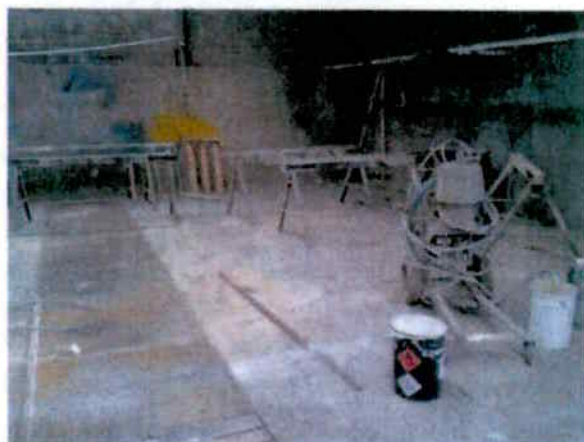
Foto 6: Verfspuitgelegenheid (niet in gebruik door Hazeleger metaal) in zuidelijk deel van pand
